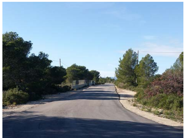
Vial principal zona sud asfaltat
