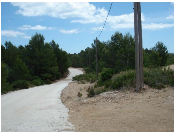
Vial amb paviment de formigó
